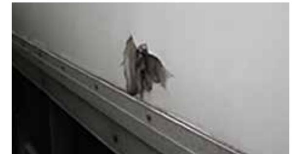
Paneles laterales de madera: Soporte de madera deteriorado  $\geq 20$  cm
