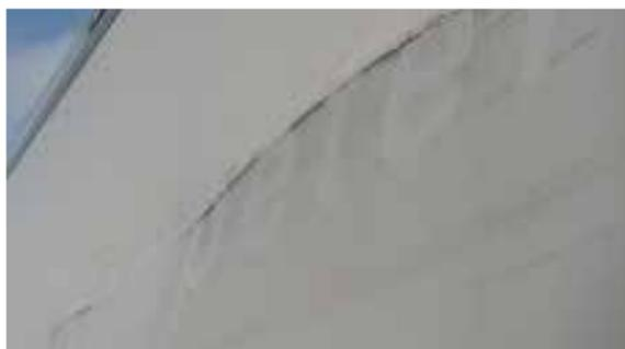
Panel laterales de fibra: Deformación en la parte inferior, longitud > 1 m
