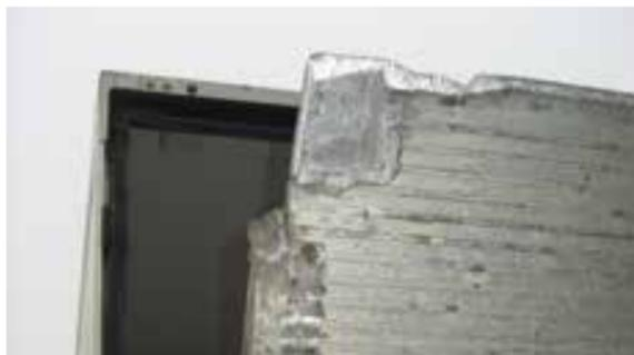
Compuerta de carga: Deformaciones de la plataforma que no merece la pena de reparar, revestimiento roto o incompleto
